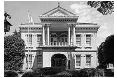
移築・保存された鳳翔閣玄関
